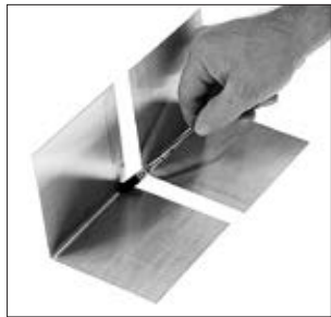
Auftragen des Flussmittels
